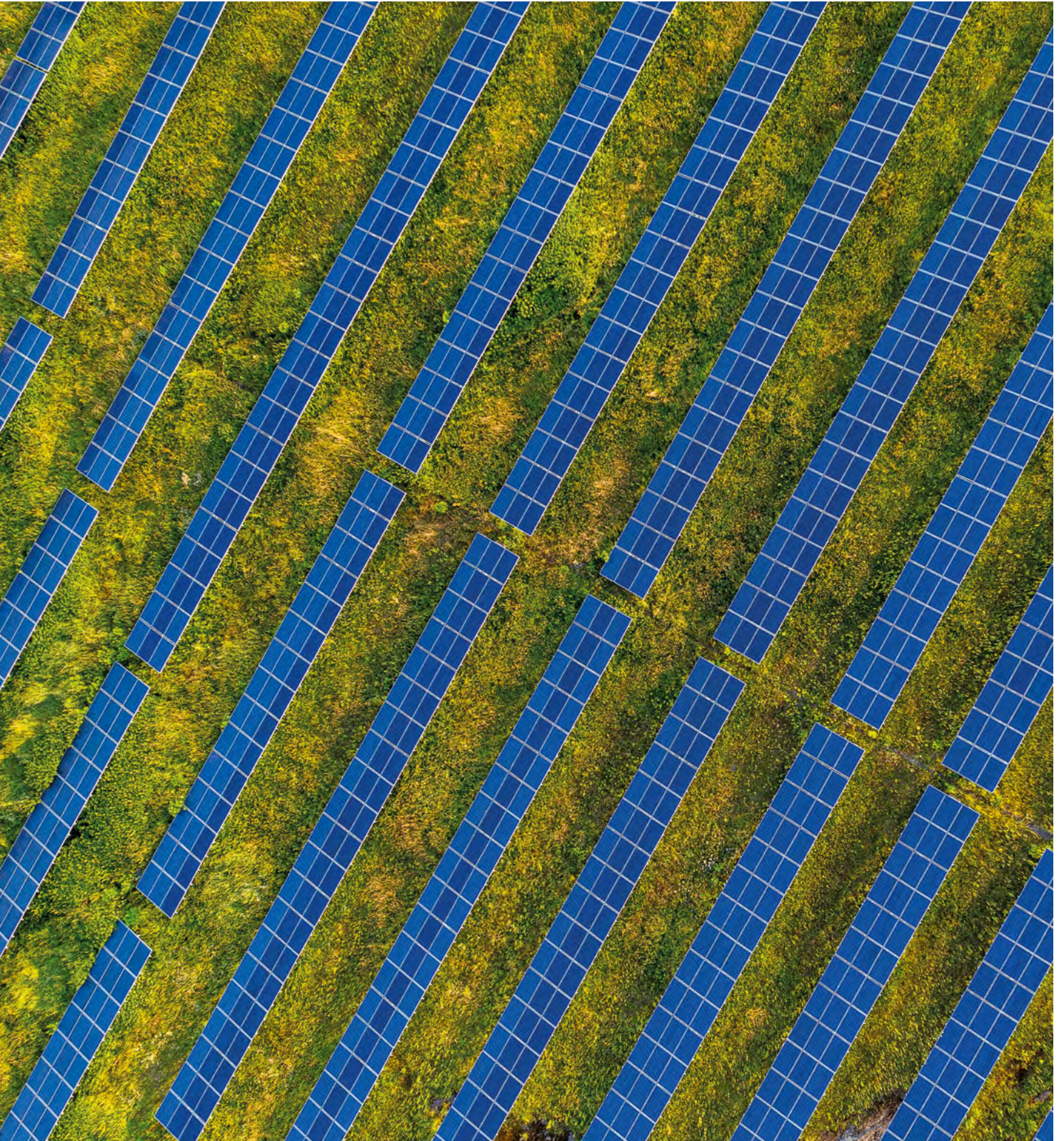
Bild: Freiflächen-PV-Anlage, Solarpark Kuchen (© Björn Hänssler / Umweltministerium)
