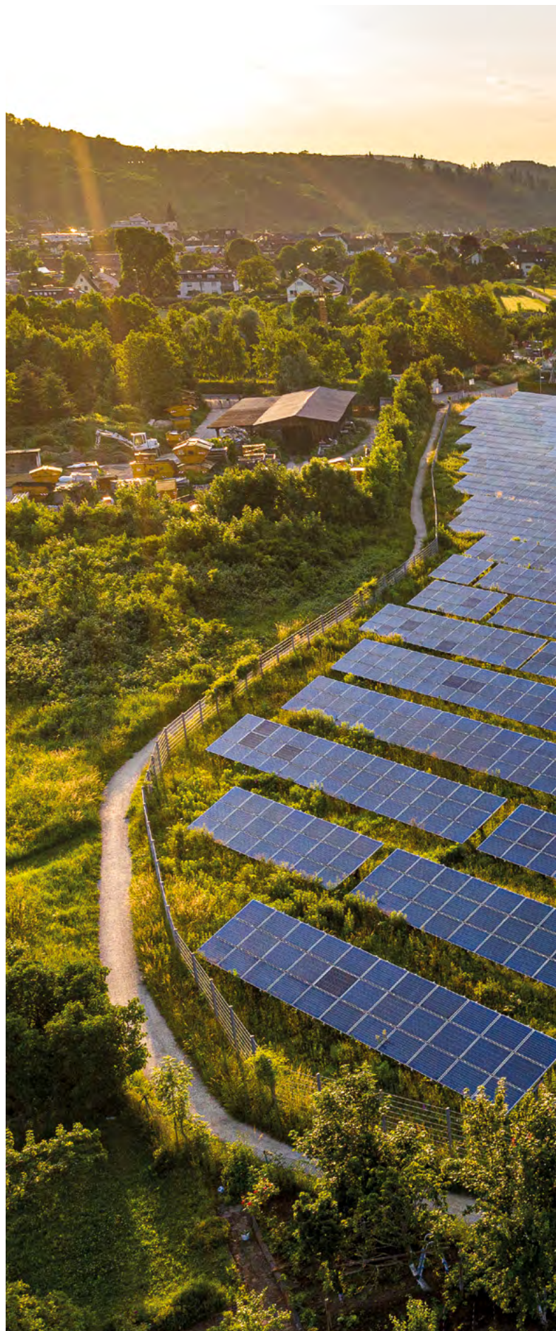
Bild: Freiflächen-PV-Anlage, Solarpark Kuchen (© Björn Hänssler / Umweltministerium)
