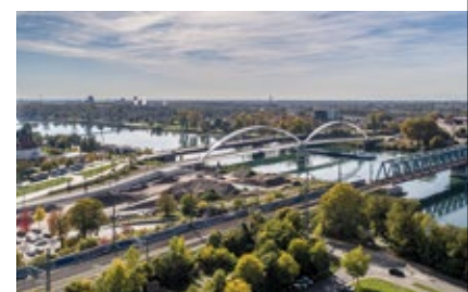
Le Rhin traversé de quatre ponts près de Kehl
